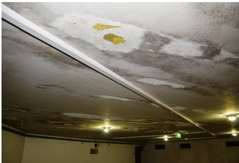
Große Anzahl von wasserführenden Trennrissen im Einfahrtsbereich, Deckenunterseite 2.UG
