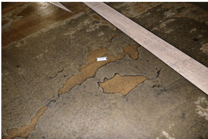
Abplatzungen des Oberflächenschutzsystems, abgenutzte bzw. abgefahrte Bereiche
