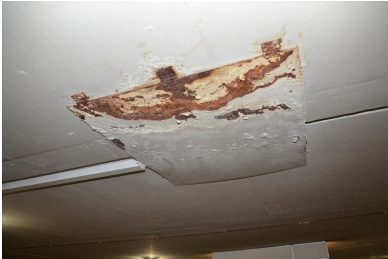
Bleche an den Tiefpunkten über der Fahrbahn an den Dehnungsfugen
