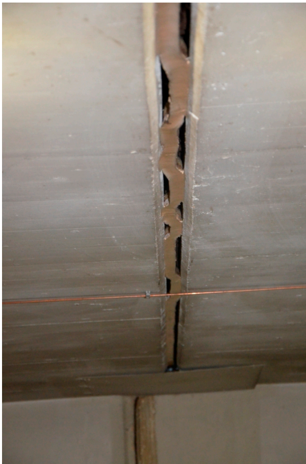
Öffnung der Dehnungsfugen um 2-3 cm
