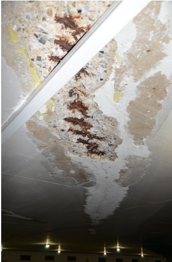
Wasserführender Trennriss mit Betonabplatzungen und freiliegender korrodierter Bewehrung, Deckenunterseite 2.UG
