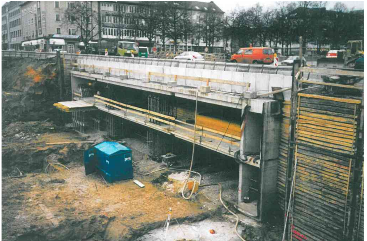
Ansicht Tiefgaragenquerschnitt an der Dehnungsfuge bei Achse 19
