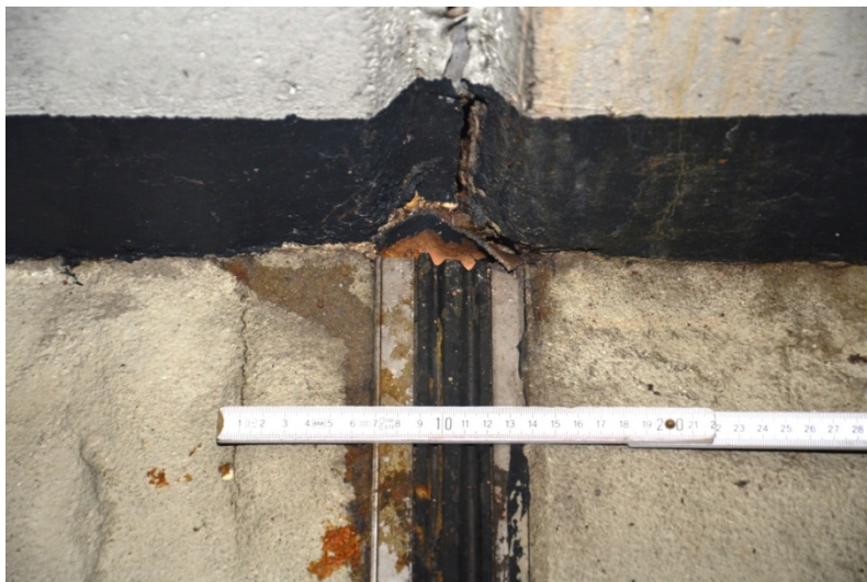
Undichtetes und umläufiges Fugenprofil in der Dehnungsfuge, Oberseite Decke über 2.UG
