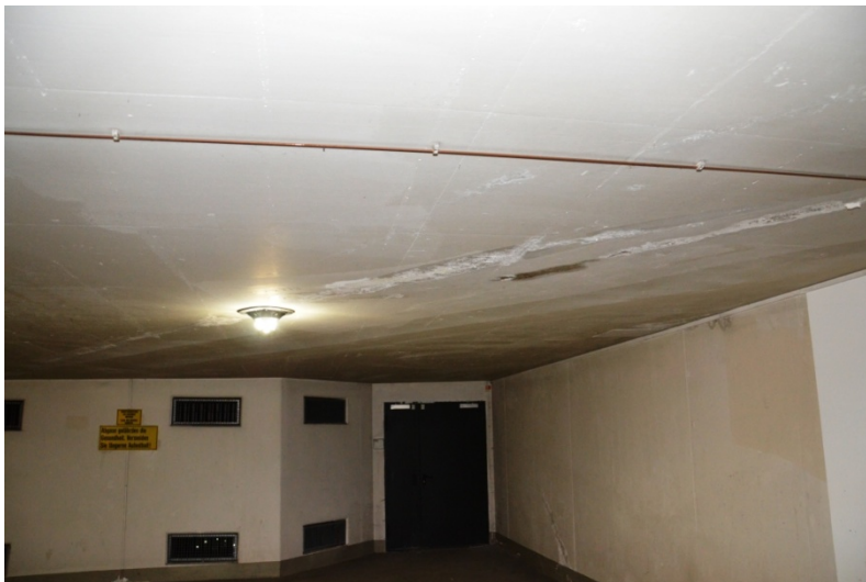
Wasserführender schräger Trennriß im Bereich Achse F/1, Deckenunterseite 2.UG
