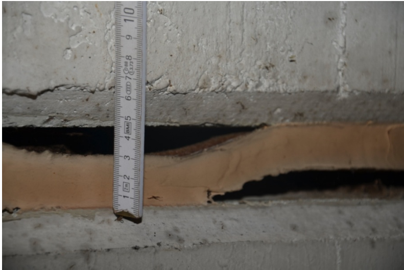
Öffnung der Dehnungsfugen um 2-3 cm
