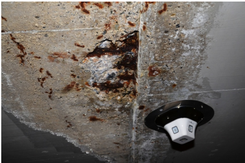
Großflächige Aussinterungen und Feuchtestellen einschließlich korrodierter Bewehrung im Bereich der Betonierfuge, Decke über 2.UG
