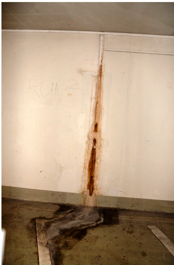
Eindringendes Wasser im 2.UG, Außenwand Achse E/0
