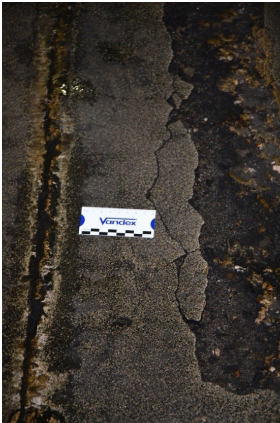
Ausgebrochene Betonierfuge oberseitig 1.UG mit abgeplatzter Beschichtung
