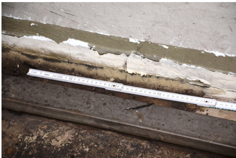
Metallschiene im Tiefpunkt vor der Wand im 2.UG, Achse C
