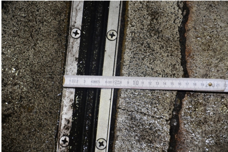
Undichtes und umläufiges Fugenprofil in der Dehnungsfuge, Oberseite Decke über 2.UG
