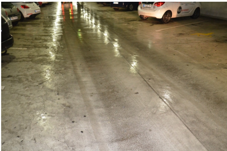
Abgefahrene Oberflächenschutzsysteme
