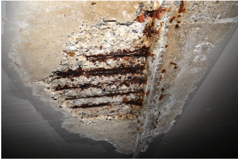
Betonabplatzungen mit freiliegender korrodierter Bewehrung an der Betonierfuge, Decke über 2.UG
