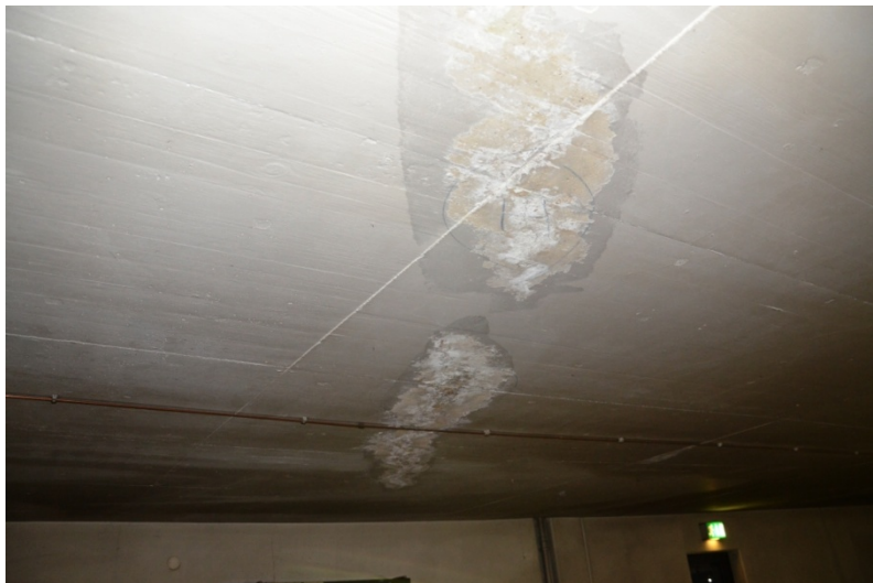
Trennrisse Deckenunterseite 2.UG mit Aussinterungen
