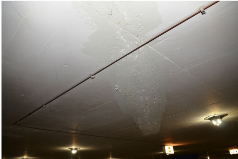
Trennrisse Deckenunterseite 2.UG mit Aussinterungen
