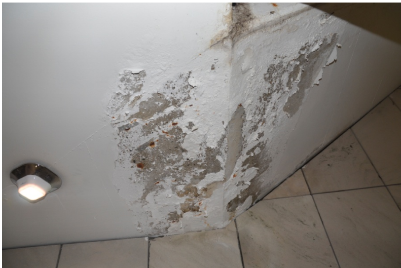
Undichte Einläufe und Anschlussfugen an den nicht überdachten Treppenzugängen
