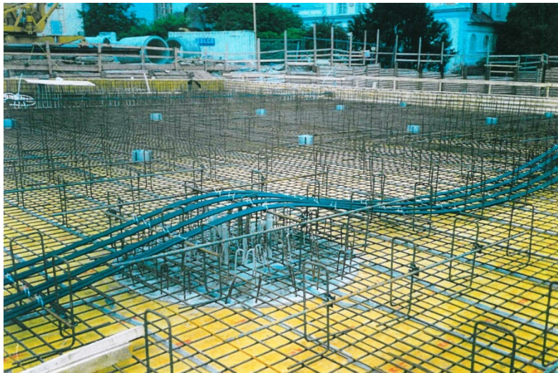
Detail Spanngliedführung über Stützenkopf
