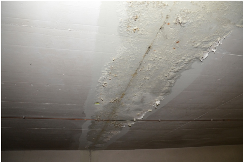
Durchgehender Trennriss an Achse 10 mit Aussinterungen
