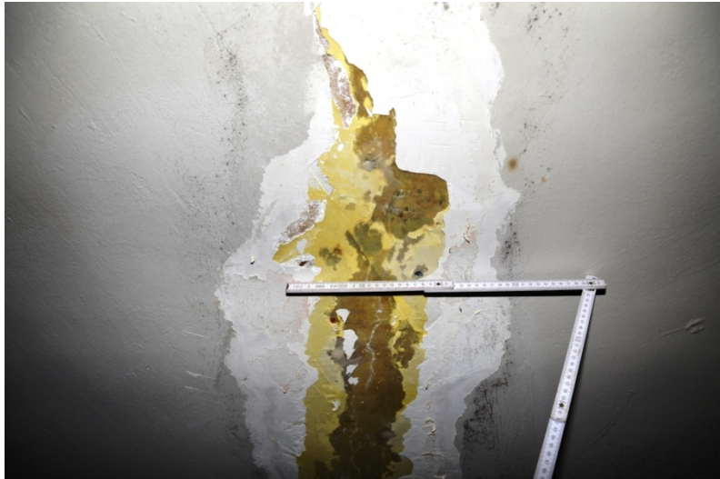
Sanierungsversuch eines Trennrisses, Deckenunterseite 2.UG
