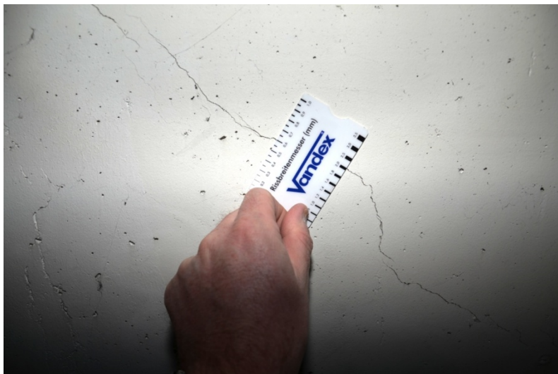
Setzungsriß an Achse F/0
