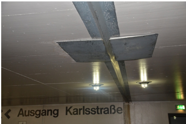
Rinne und Blech unter der Dehnungsfuge Achse 5
