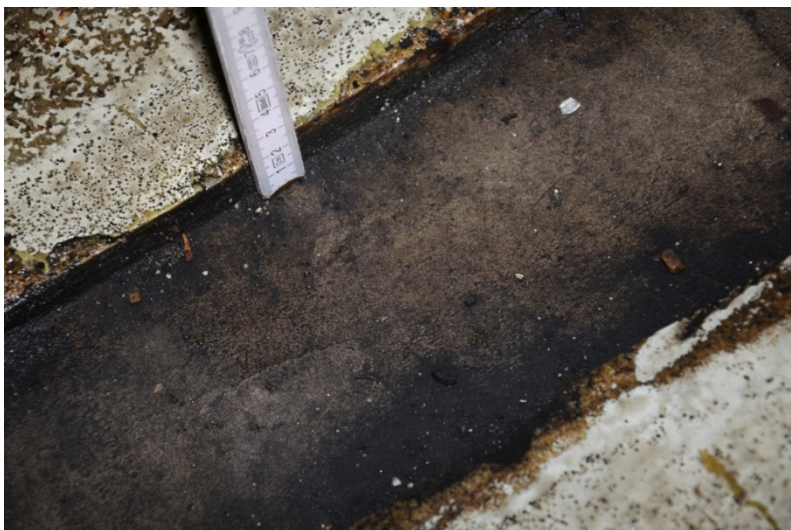
Eingefräste Nut in die Sohle 2.UG im Bereich des Brandschutztores Achse 6
